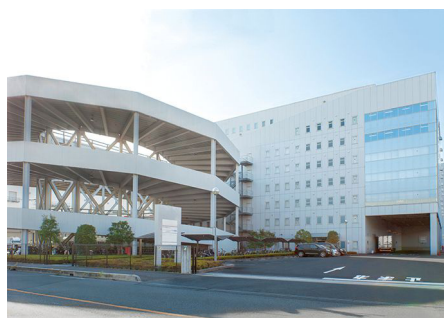
写真1 「草加常温センター」が入居する物流施設
