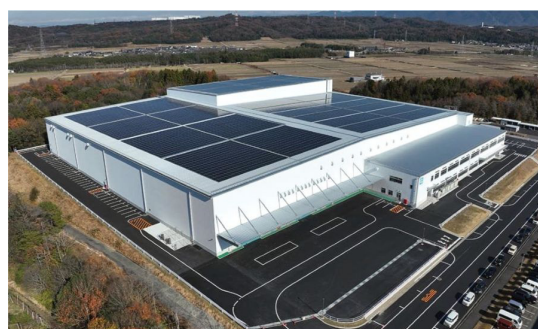
写真 竣工した新工場棟の外観 ※(株)ダイフク提供
