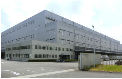
写真4 八王子配送センターの外観
