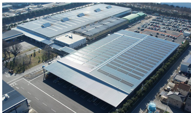
写真1 太田ドア工場・物流棟屋根の太陽光パネル
