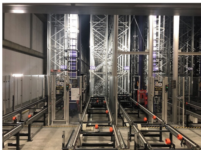
写真3 パレット自動倉庫
