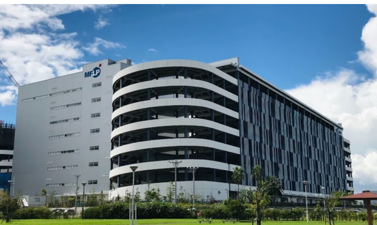
写真1 関東品質管理センターが設置されている マルチテナント型物流施設「MFLP船橋Ⅰ」
